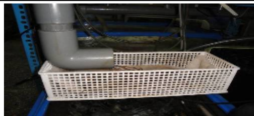
17. 排水口設一彎管先將廢水引導經一層海棉，過濾較大顆粒的廢物。
