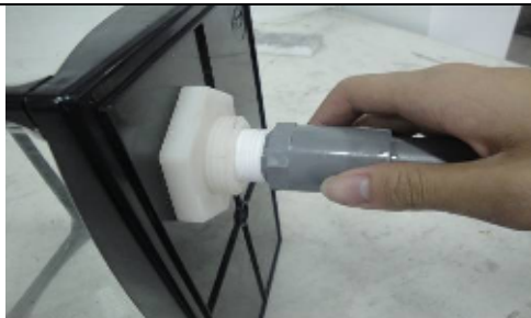
圖 5. 把止水閥的螺旋纏繞約一至兩圈的止水帶
