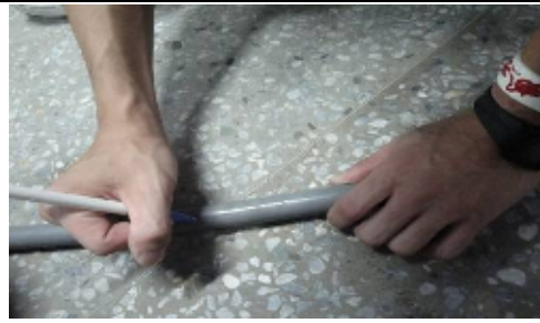
圖 11. 測量各個魚缸對水管的中間，並在水管上做記號。
