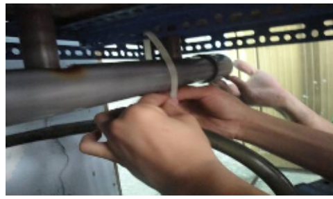
圖 20. 將排水管用束帶固定在最近的鐵架
