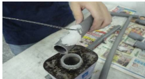
圖 22. 每一個水管與水管相接部位拆起塗上水管膠。
