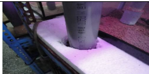
圖 15. 用自由鑽在左後方避開魚缸的位置，鑽出直徑>40mm(40mm 為管徑)的洞
